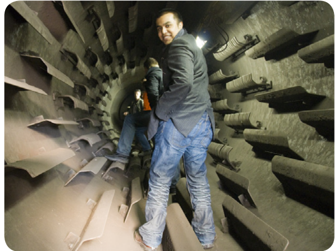
Radjan Khedoe in een asfaltmenger (tijdens een onderhoudsbeurt)
