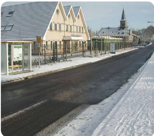
Het zonnecollectorwegdek voor het Research Center van Ooms in Scharwoude
